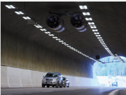
TUNNEL VT1 2 LAHTI (FINNLAND)
