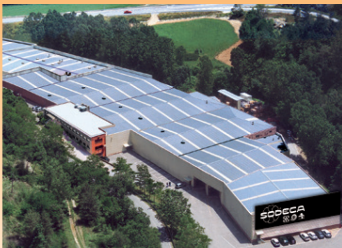
Installations centrales de SODECA S.L.U., à Sant Quirze de Besora
