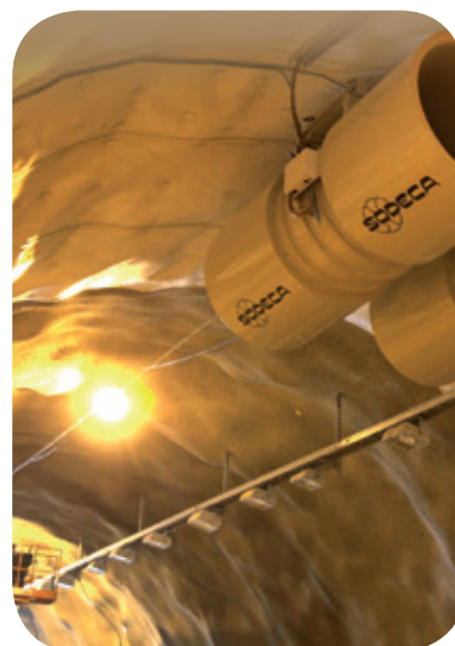
APPLICATIONS INDUSTRIE MINIÈRE ET TRAVAUX PUBLICS
